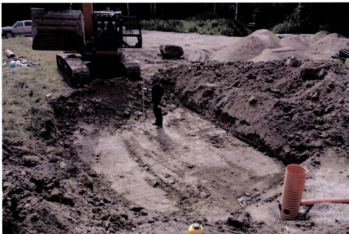
Figur 2. Schaktbottennivå mäts in inom området för anläggandet av R12-R14.
