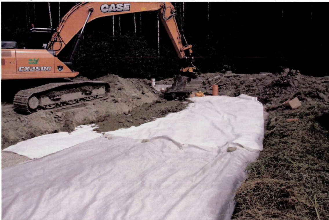
Figur 5. Spridningsledningarna kopplas in från brunnen och anläggs ovan spridningslagret. Ledningarna täcks därefter med samma material som spridningslagret.
