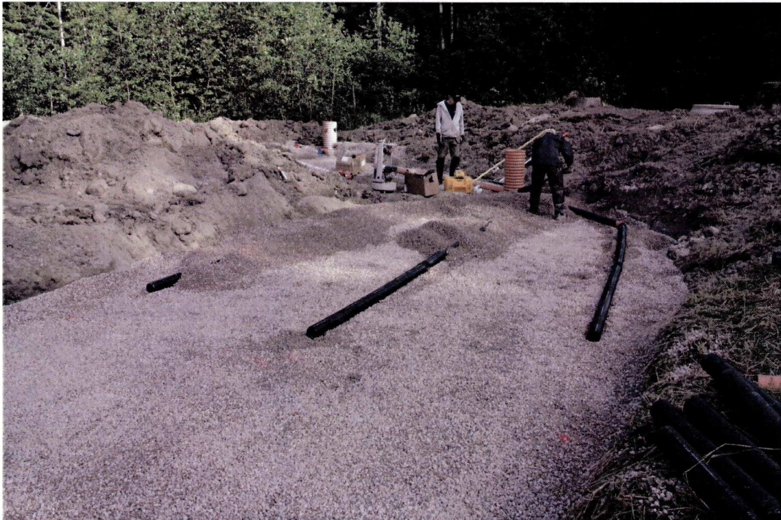
Figur 5. Spridningsledningarna kopplas in från brunnen och anläggs ovan spridningslagret. Ledningarna täcks därefter med samma material som spridningslagret.
