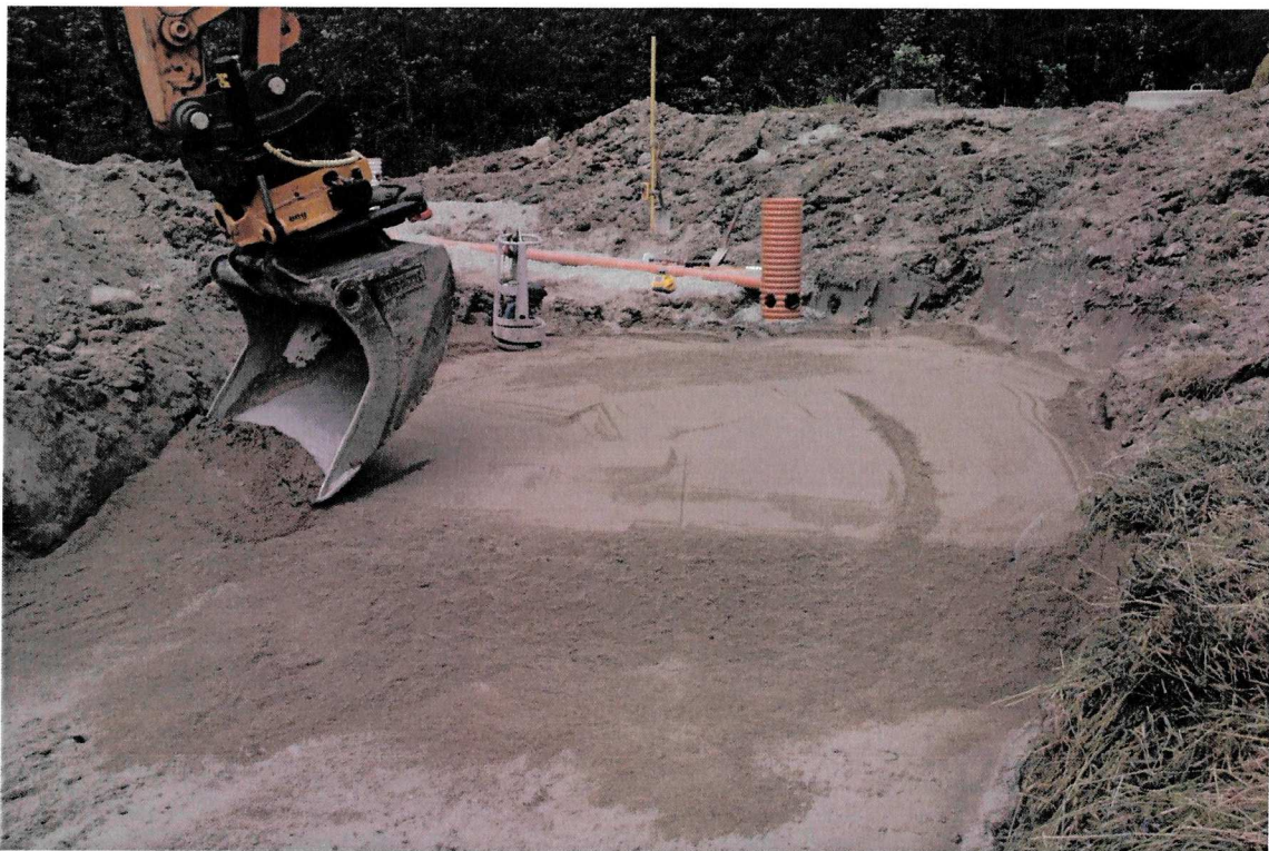
Figur 3. Förstärkningsbädd anläggs ovan schaktbotten.
