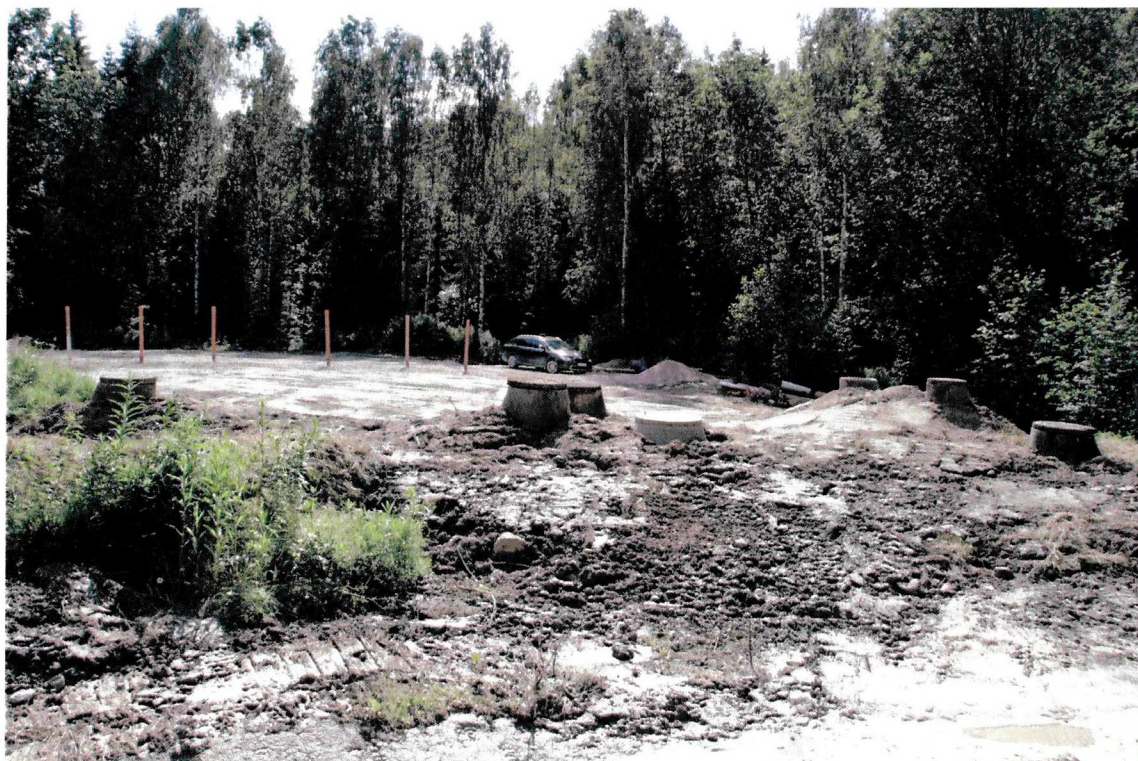
Figur 7. Avluftningsrör från spridningsledningarna vilka installerats i nivå ovan förväntat snödjup.
