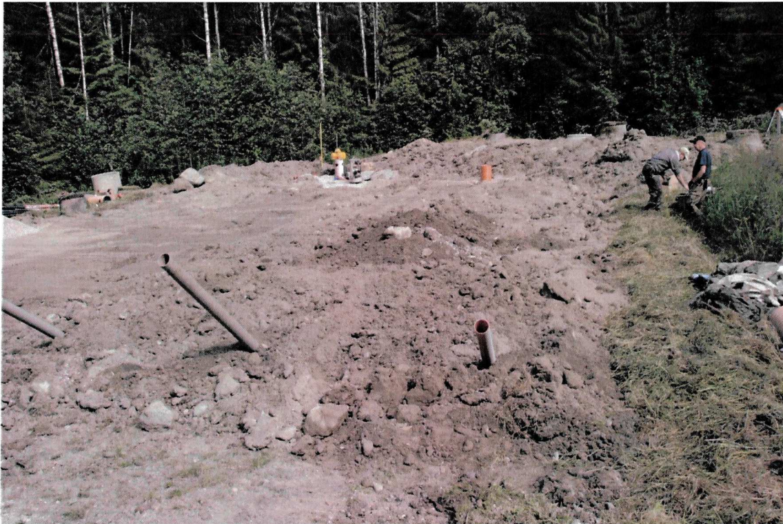
Figur 7. Avluftningsrör från spridningsledningarna vilka installerats i nivå ovan förväntat snödjup.
